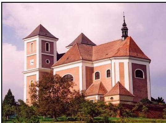
KOSTEL V POZOŘICÍCH
